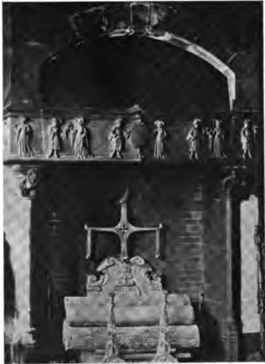
Fig. 124 — Cheminée du xv e siècle au Musée de Cluny. Arc de décharge protégeant la hotte et le linteau orné.
